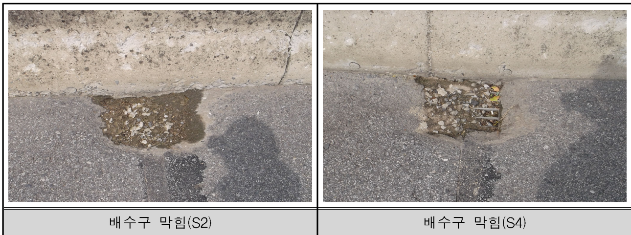
【표 3.1.10】 배수시설 외관조사 현황
