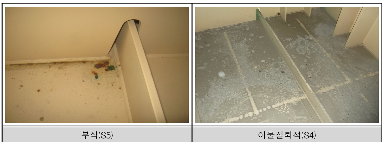
【표 3.1.2】 강 거더 및 가로보 외관조사 현황
